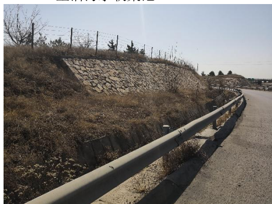
边坡防护及排水沟
