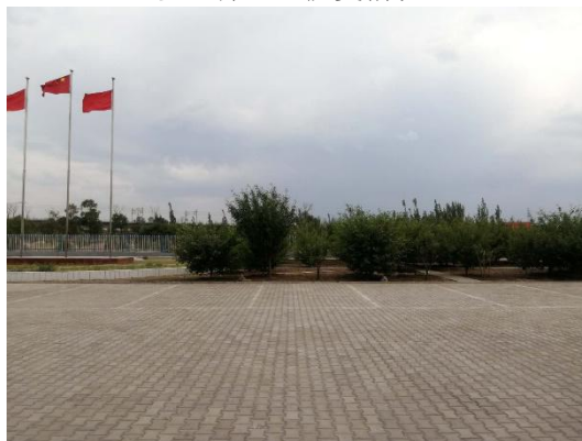
大路收费站生活区硬化措施
