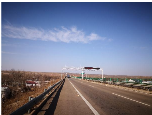
项目起点（城壕，黄河大桥）
