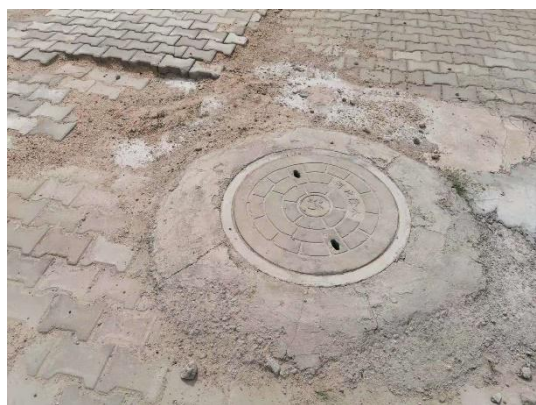
生活污水收集池
