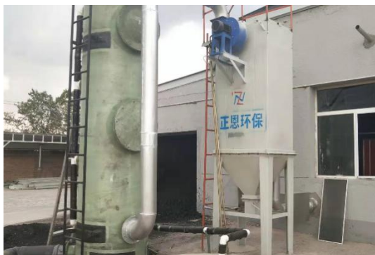
薛家湾收费站生活区锅炉
