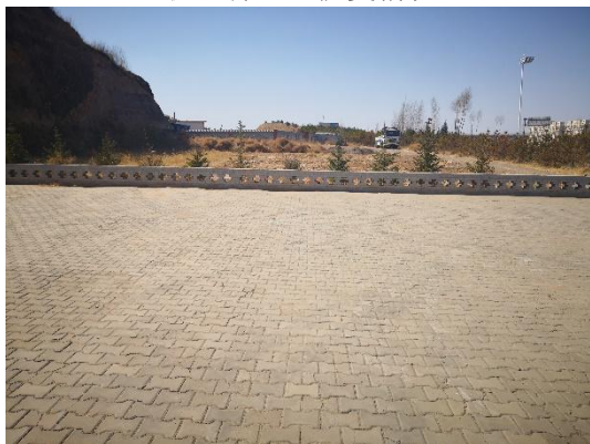
薛家湾收费站生活区硬化措施
