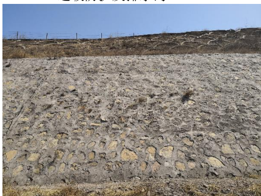
混凝土护坡
