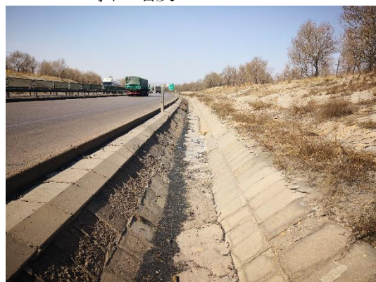
导流槽及排水沟
