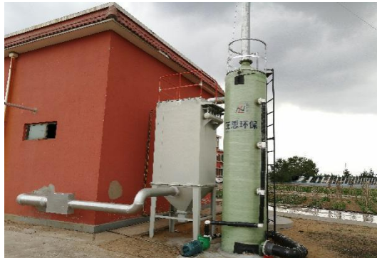
大路湾收费站生活区锅炉
