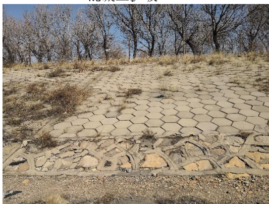
边坡砌块防护
