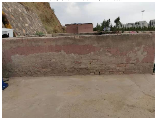
大路收费站生活垃圾收集池
