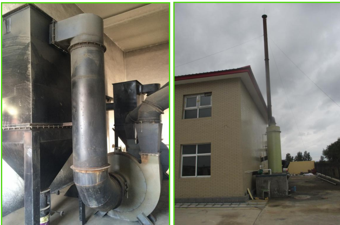
陶瓷多管除尘器+玻璃钢脱硫除尘器
