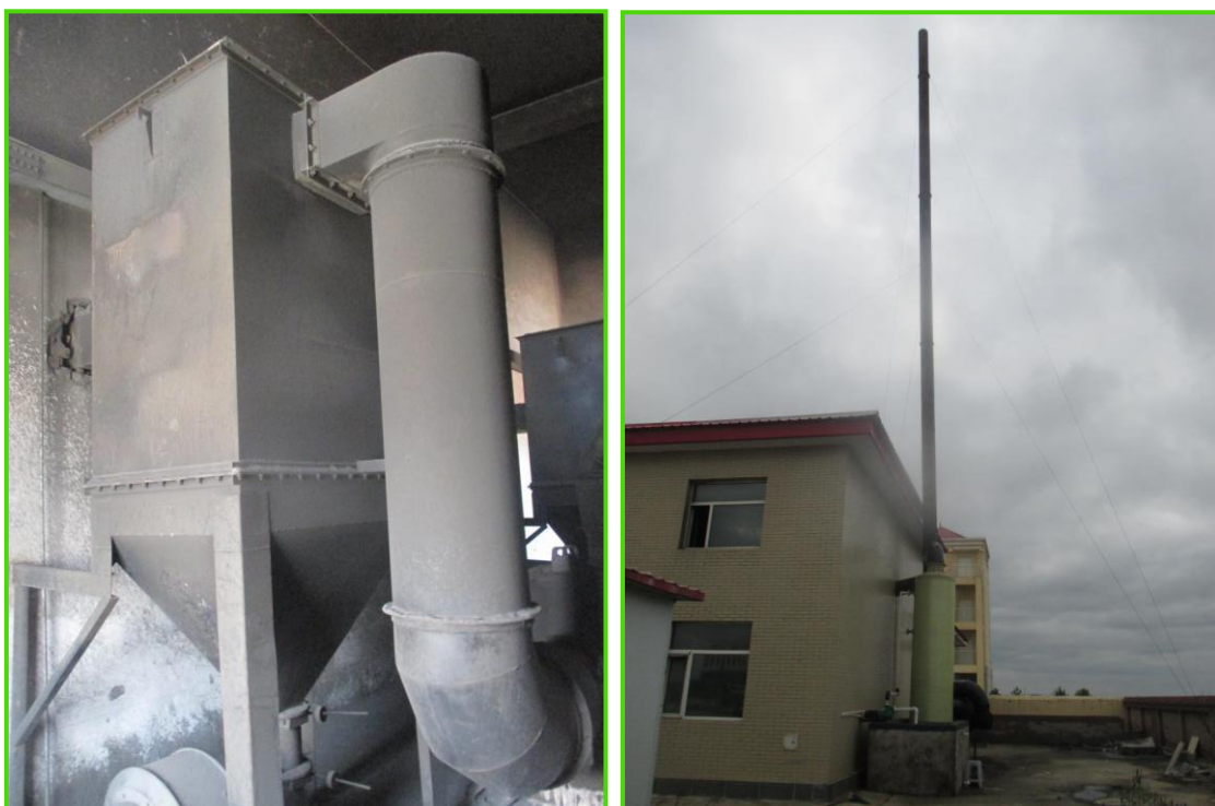
陶瓷多管除尘器+玻璃钢脱硫除尘器
