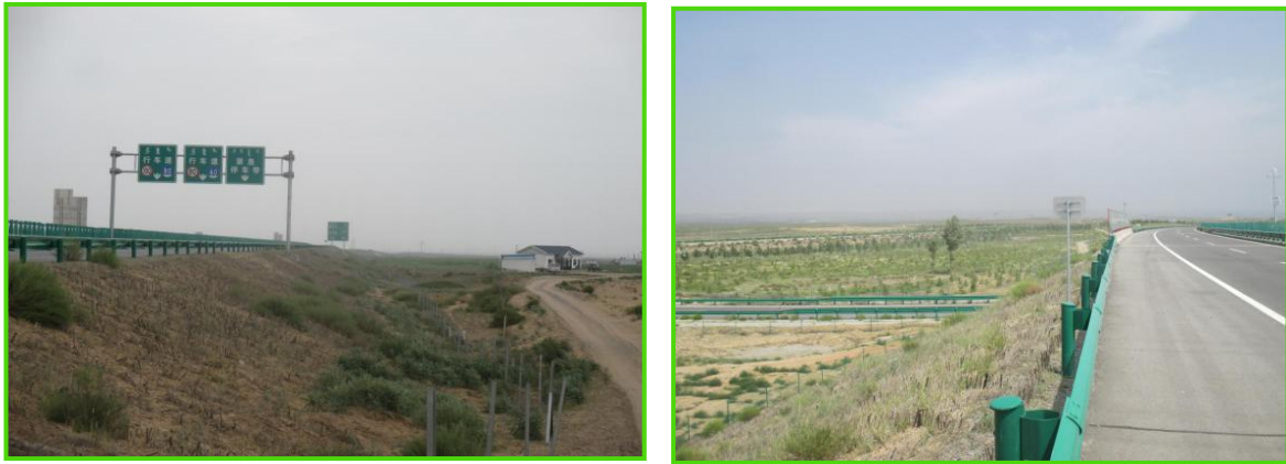
路基沙柳网格及预制块防护
