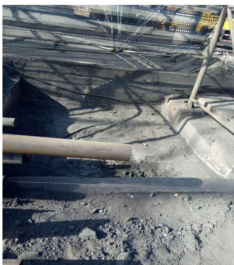
渗滤液收集池
