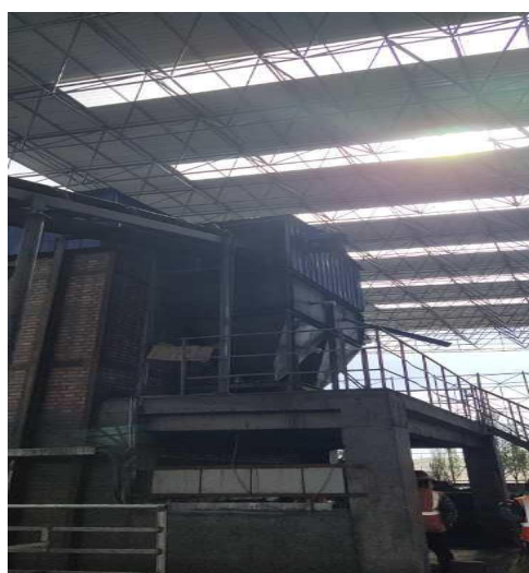
全封闭燃料煤进料口
