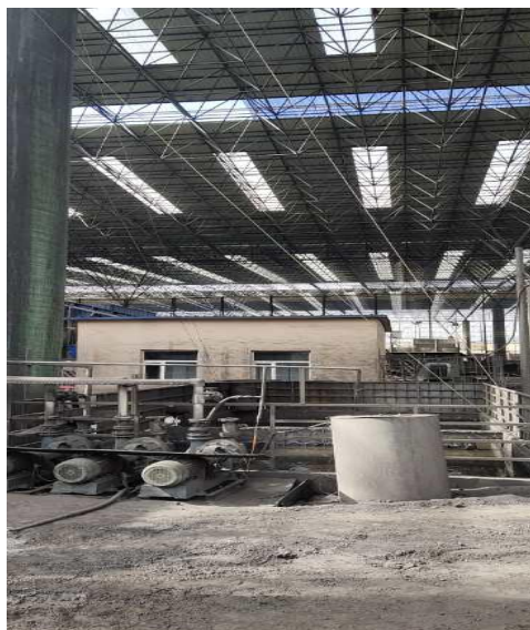
电控室和操作间
