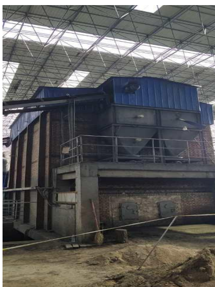
全封闭燃料煤进料口
