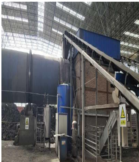
SNCR 脱硝设备
