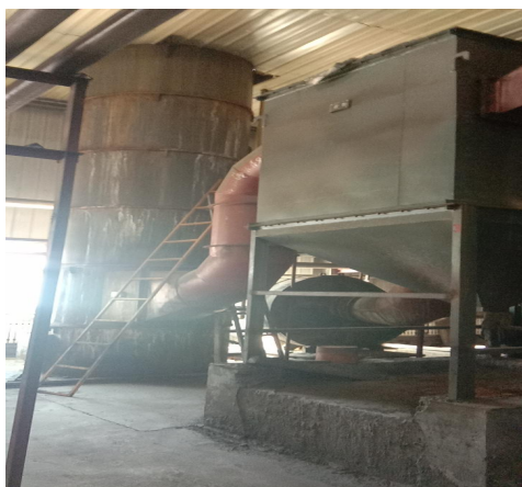
水膜脱硫除尘器
