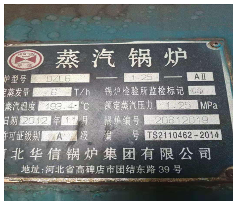
6t 蒸汽锅炉
