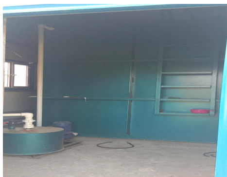
污水处理设施
