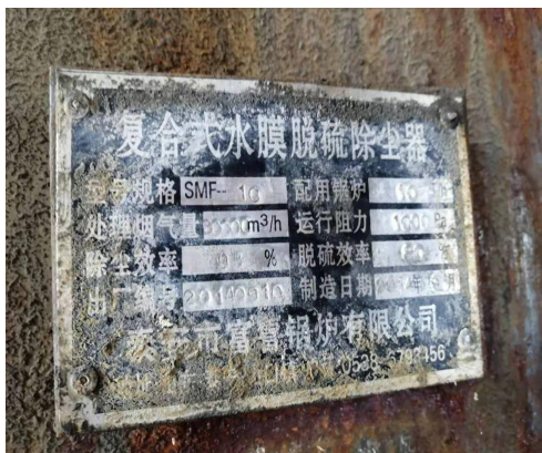
水膜脱硫除尘器名牌
