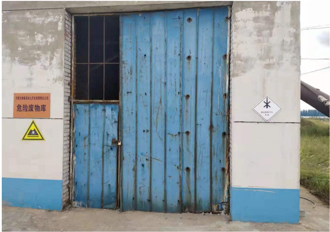
危险废物暂存库
